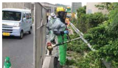
道路除草作業
