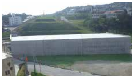
道路用BOX工事
