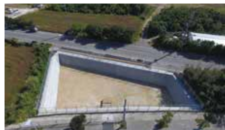
冠水対策工事
